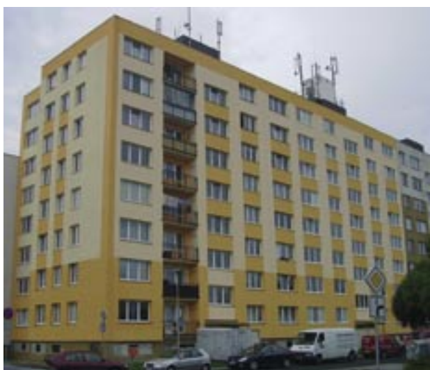
Panelový dům Opava
