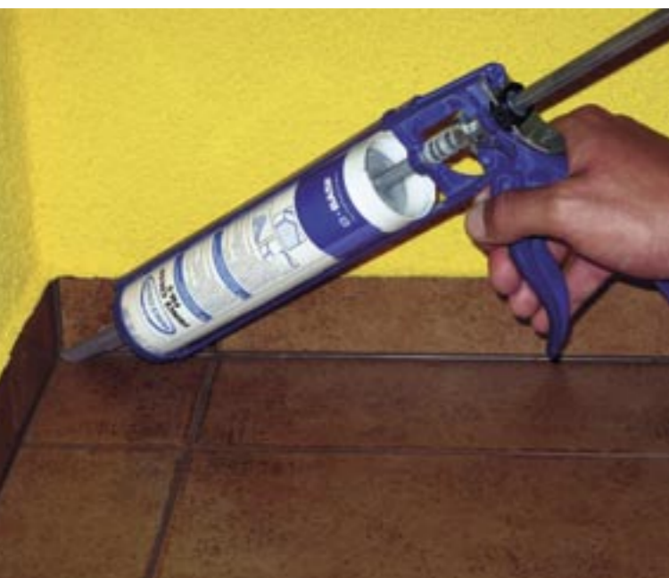
Třístranné přilnutí tmelu ve spáře
